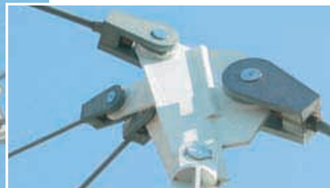
Изящно и в то же время под воздействием огромной нагрузки: крепление несущего троса кровельной конструкции
