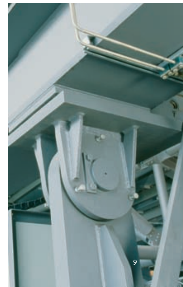
Шарнирные подшипники в стойках под трибуной: в откинутом положении они позволяют выдвигать и задвигать газон.
